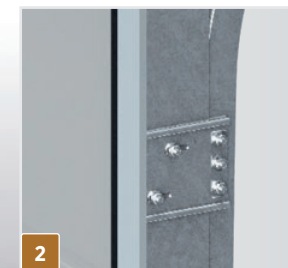
Looprails vastgeschroefd aan het frame
