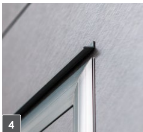
4 Waterslagprofiel (standaard).
