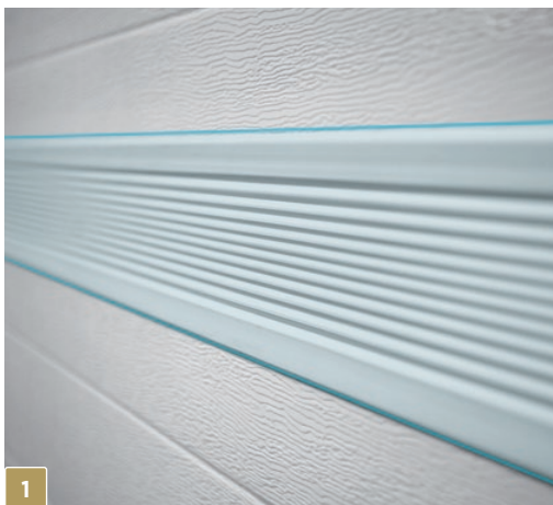
Flexibele afdekkingen tussen de panelen
