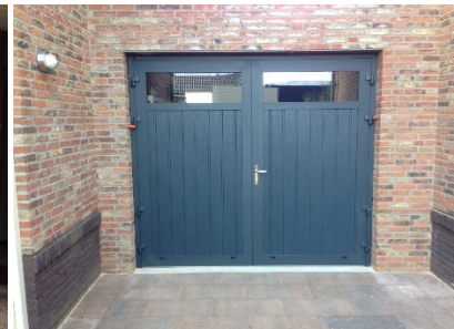
Horizontaal geplaatst glasstrook in verticaal geprofileerde deur
